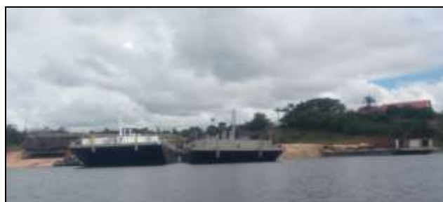
Figura 6. Construção de balsas metálicas na margem direita do Rio Puraquequara.
