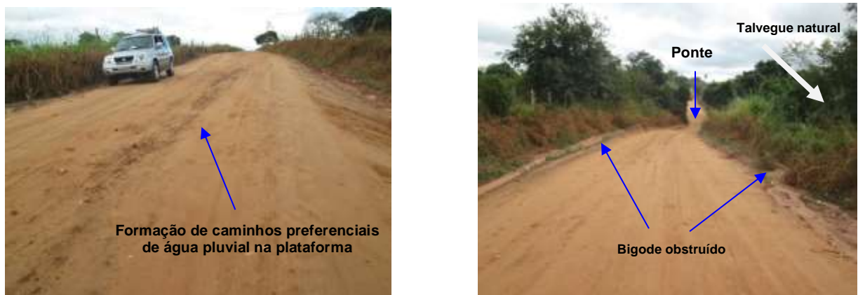
Figura 5 – Registro fotográfico do Ponto 4.
