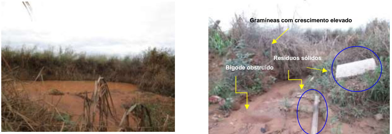
Figura 3 – Registro fotográfico do Ponto 2.
