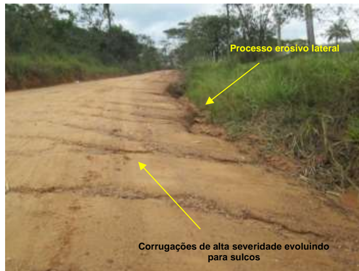
Figura 6 – Registro fotográfico do Ponto 5.
