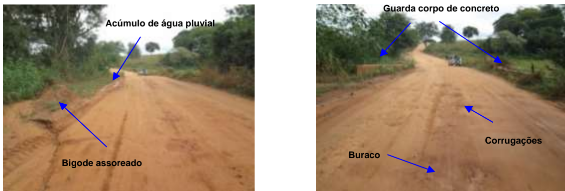
Figura 4 – Registro fotográfico do Ponto 3.
