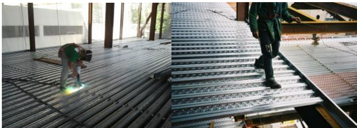
Figura 7 – Execução das chapas na laje
