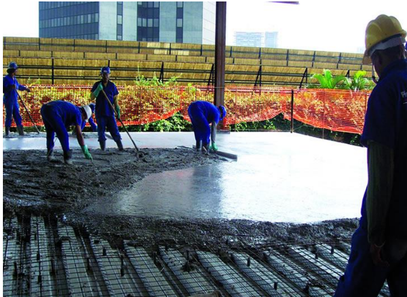
Figura 6 – Concretagem da laje
