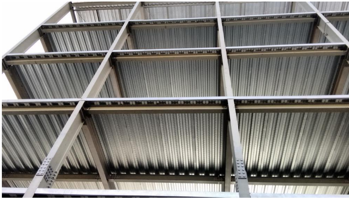
Figura 1 – Aplicação de steel deck em vários andares
