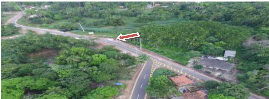
Figura 6. Interligação entre os bairros Turu e Parque Vitória (Ponte Pai Inácio).
