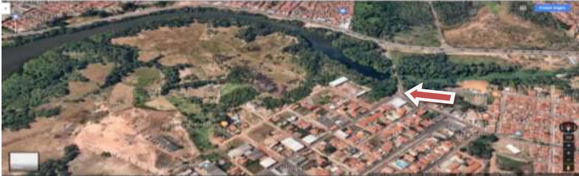
Figura 5. Ponte que interliga o bairro Parque dos Nobres à cidade.
