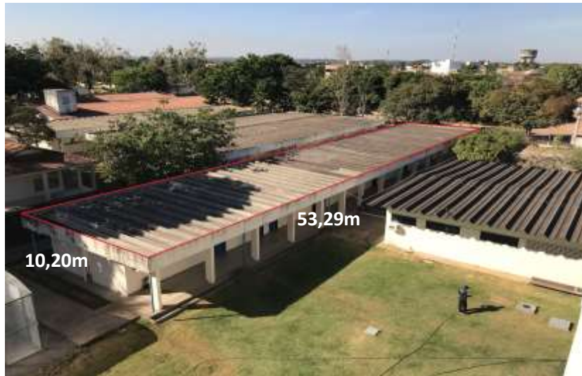
Figura 2 - Cobertura do bloco I da UEPA.
