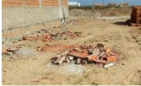
Figura 3. Resíduos de construção da Obra 1.
