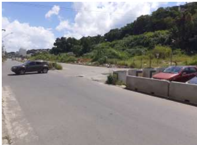
Figura 2 – Ausência de placas de sinalização e marcações no asfalto e via parcialmente bloqueada.
