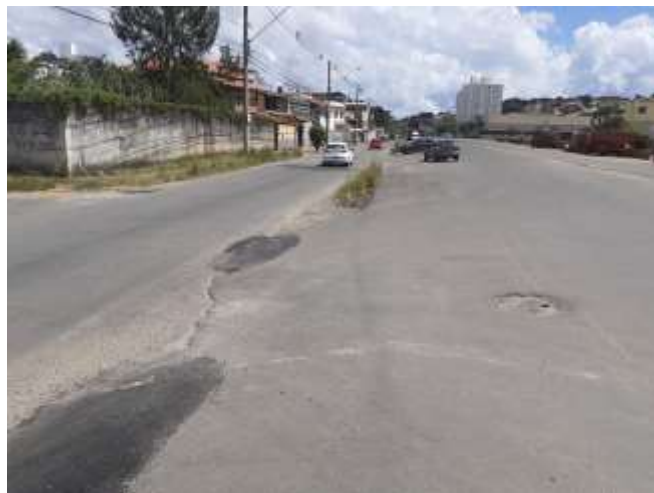
Figura 3 – Veículos realizando conversão à Avenida Pedro Henrique Krambeck, paralela à BR-440.
