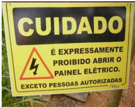
Figura 8 - Sinalização em uma das áreas do canteiro de obras.
