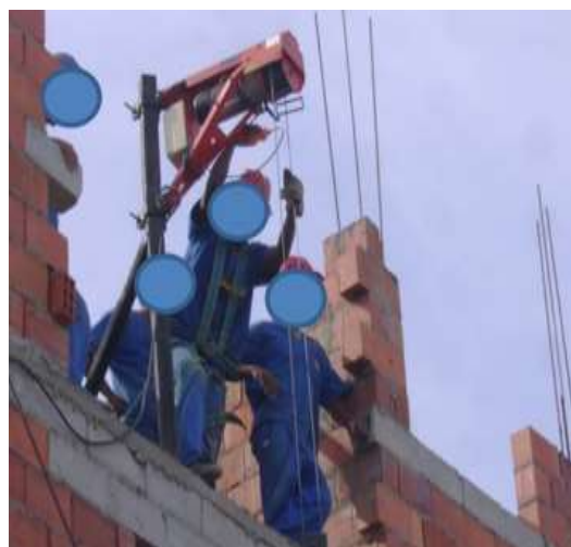
Figura 4 - Situação do trabalho em altura no canteiro de obras visitado com profissional bem equipado.
