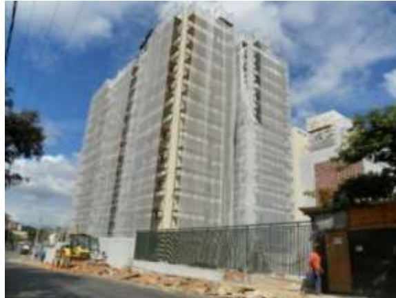
Figura 1 - Empreendimento da construtora analisada.
