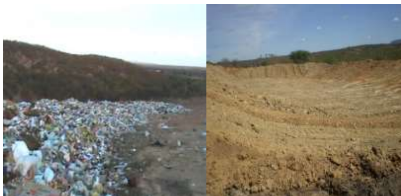
Figura 2. Antigo lixão da cidade e trincheira aberta para acondicionar o lixo em aterro controlado.
