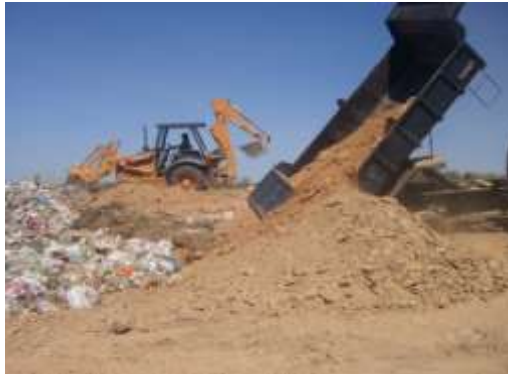
Figura 3. Cobertura do lixo sendo realizada no Aterro Controlado.
