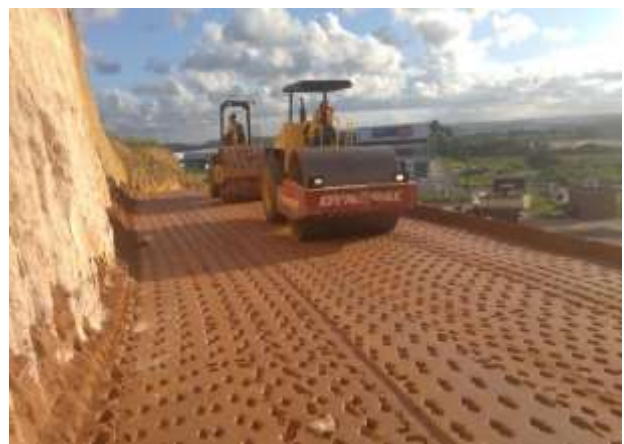
Figura 8 - Compactação da última camada (Laser Eletro).
