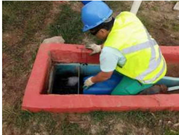
Figura 2. Coleta do lixiviado na Calha Parshall do aterro sanitário.
