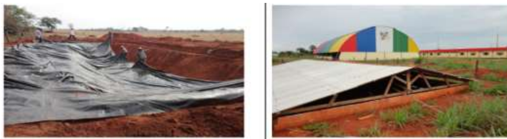
Figura 3: Implantação de cisterna na escola estadual 12 de outubro.
