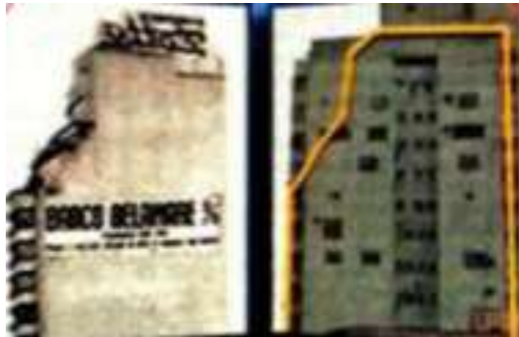
Figura 3. Diferenças entre a fachada do Edifício Liberdade.
