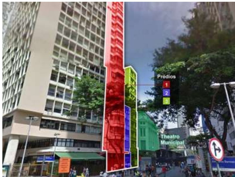
Figura 1: Vista dos fundos do Teatro Municipal.
