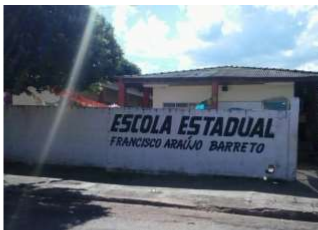
Figura 1. Fachada de la Escuela Estatal Francisco Araújo Barreto, donde se aplicó la intervención.
