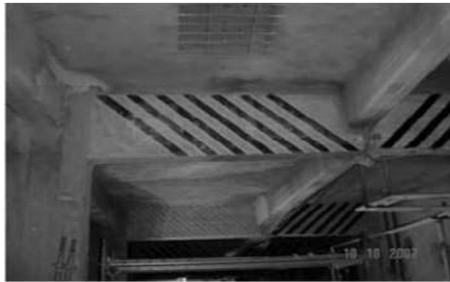
Figura 11 - Reforço de viga ao corte com fibras de carbono.
