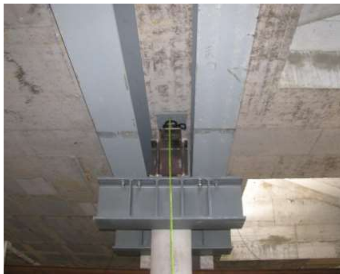
Figura 5 - Reforço com Chapa Metálica.
