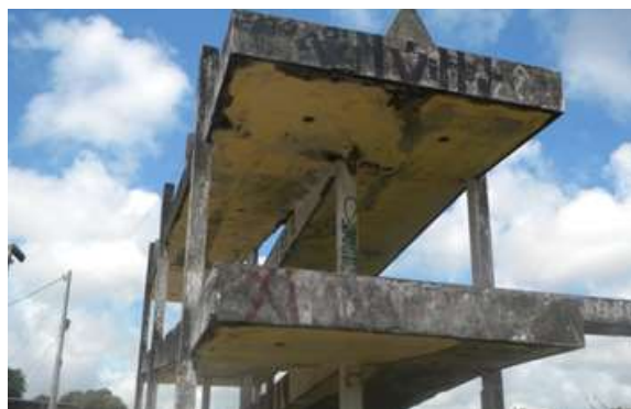
Figura 4. Vista do trecho em rampa da passarela.
