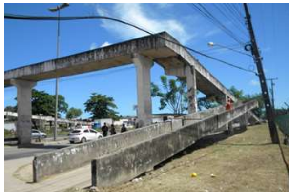
Figura 2. Vista lateral do trecho em rampa da passarela.
