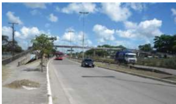
Figura 1. Vista geral da passarela.
