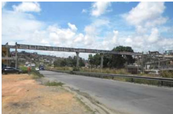
Figura 3. Vista geral da passarela.
