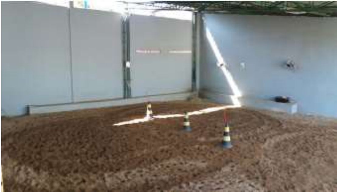
Figura 8. Picadeiro protegido e com drenagem.
