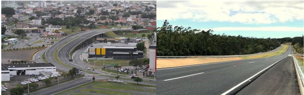
Figura 1 – Inserção da rodovia na cidade e seu entorno com vegetação consolidada.
