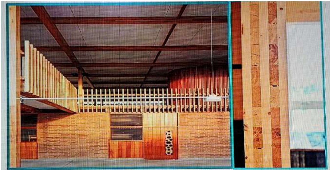
Figura 2 – Exemplo da utilização de madeira laminada colada (MLC) na moradia escolar de Canuanã – Formoso do Araguaia – Tocantins.
