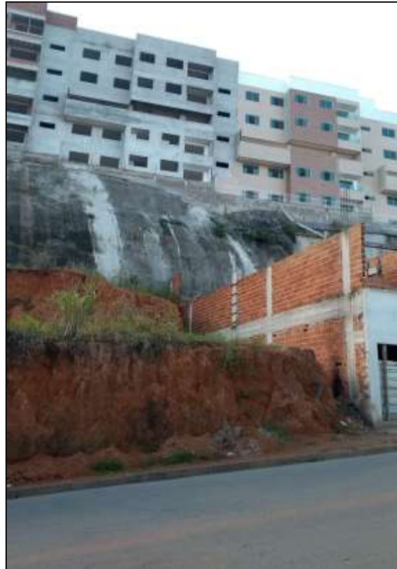
Figura 10: Muro grampeado que não tem função estrutural do solo de outro ângulo.
