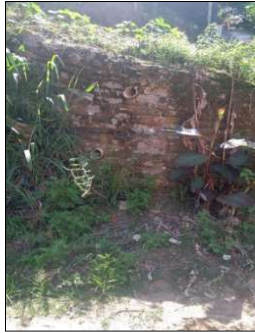
Figura 7: Muro de saco solo-cimento.
