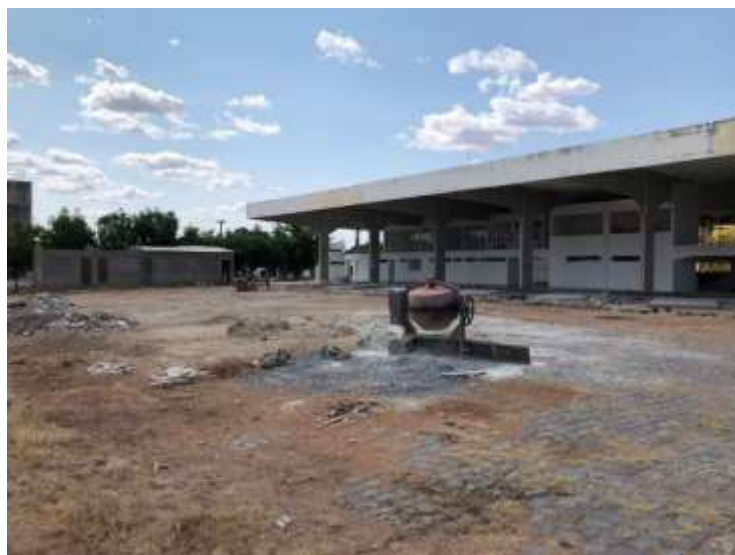
Figura 2 – Foto do canteiro de Obras da Rodoviária Adilmar de Paiva Gadelha.
