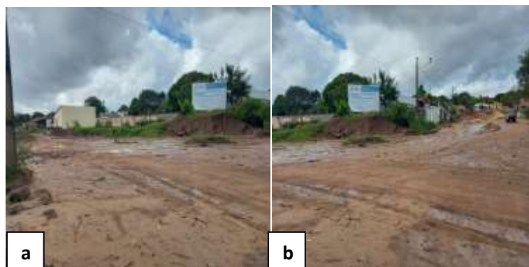
Figura 6. a) via de acesso ao bairro Maracanã, rua Araruama; b) via de acesso às residências, Rua Ponta de Pedras. Bairro Maracanã, Santarém, Pará.
