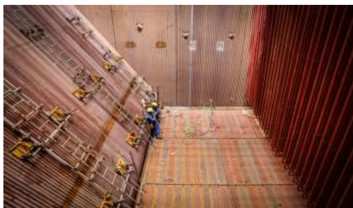
Figura 4. Caldeira de Recuperação e Caldeira de Força.
