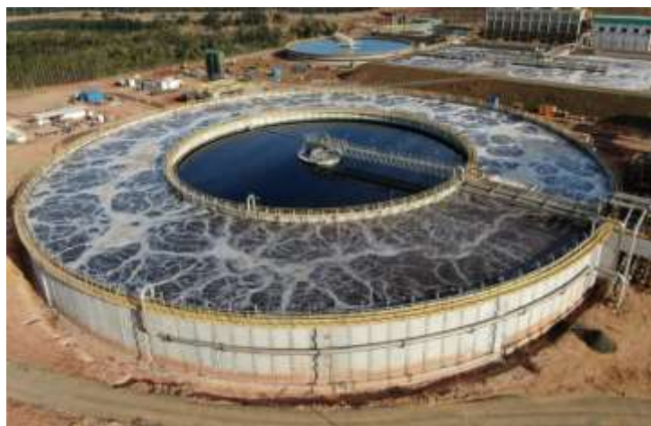
Figura 6. Estação de Tratamento de Efluentes – ETE.
