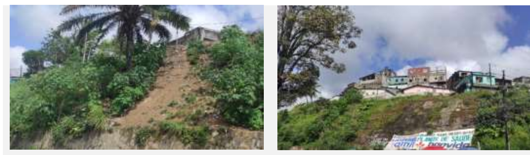
Figura 10 – Imagens da encosta principal defronte a estação do metrô Cavaleiro.
