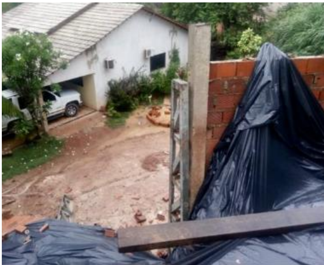
Figura 1 – Residência localizada em nível abaixo do terreno vizinho.
