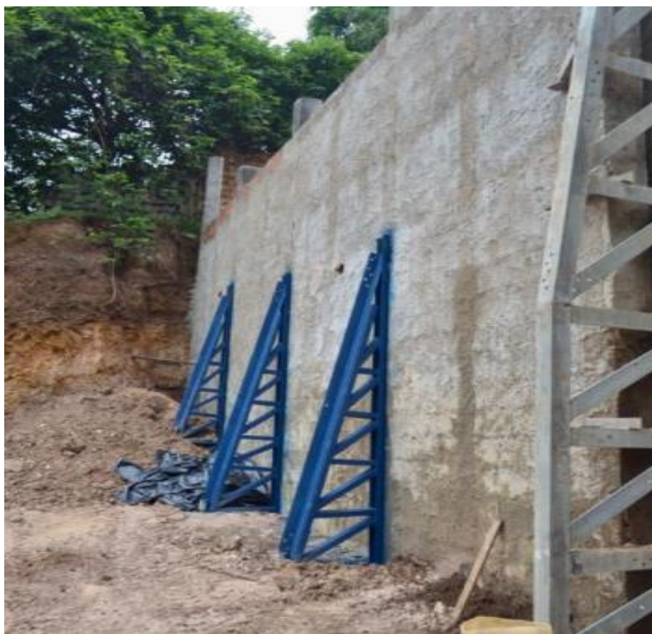
Figura 2 – Muro de contenção da divisa do terreno.
