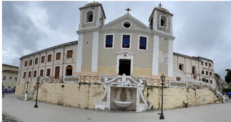
Figura 1: Vista da fachada da Igreja e Convento de Nossa Senhora do Carmo.
