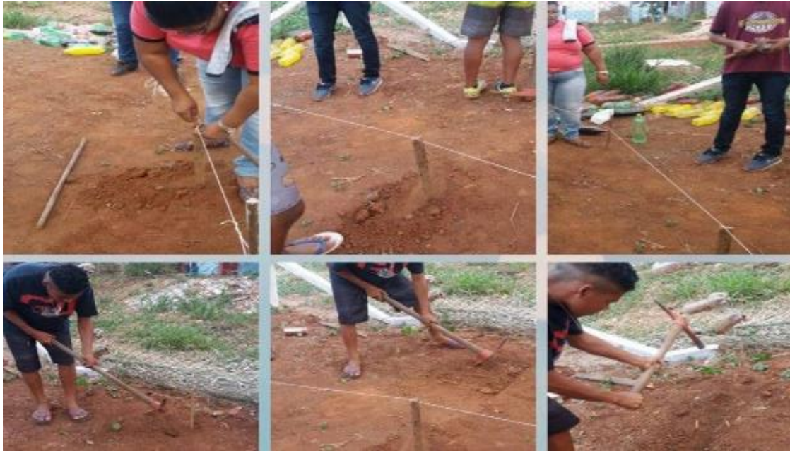
Figura 7. Delimitação dos canteiros e escavação das valas.
