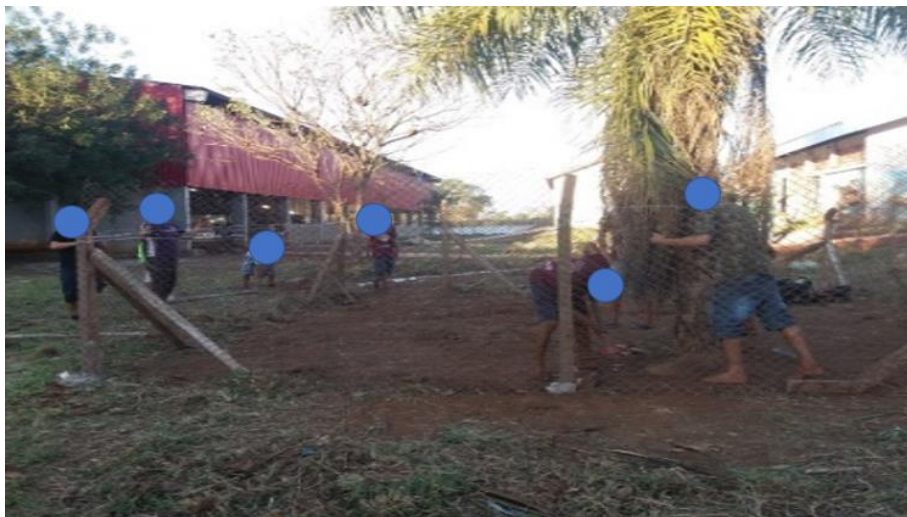
Figura 3. Trabalho de limpeza do terreno e montagem dos cercados.
