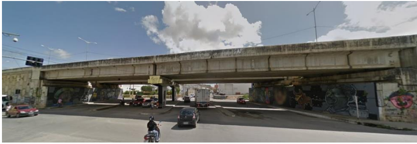
Figura 1 - Viaduto com longarinas protendidas em Caruaru-PE.
