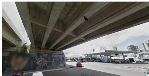
Figura 2 - Múltiplas longarinas em viaduto de Caruaru-PE.
