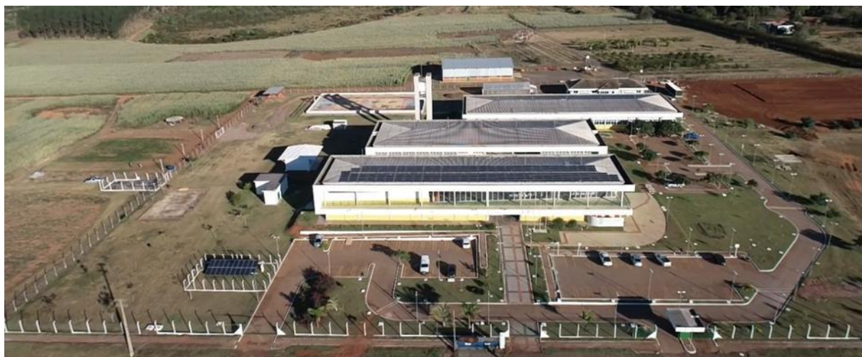
Figura 3 - Vista aérea do Campus Ponta Porã.
