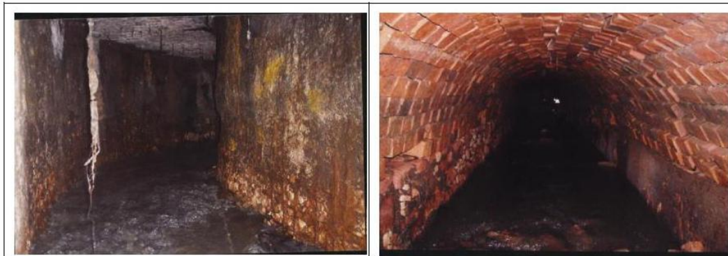
Figura 1. Galerias subterrâneas construídas pelos ingleses canalizando os igarapés.
