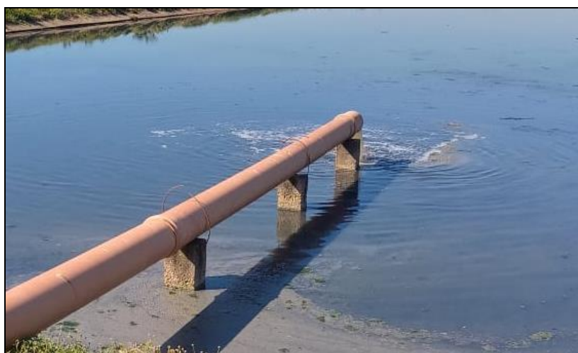
Figura 6 – Reservatório do Lodo de Esgoto (estação de tratamento).
