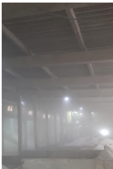
Figura 1. Ambiente inoperante por conta do pó gerado por baixa dureza.
