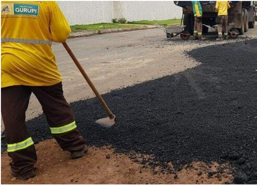
Figura 1. Emulsão asfáltica pronta para a operação tapa buracos.
