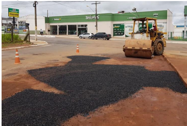
Figura 2. Processo de tamponamento com emulsão asfáltica.
