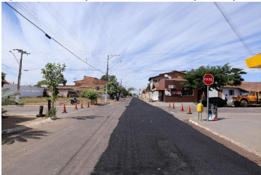
Figura 4. Processo de tamponamento com asfalto diluído de petróleo em processo.
