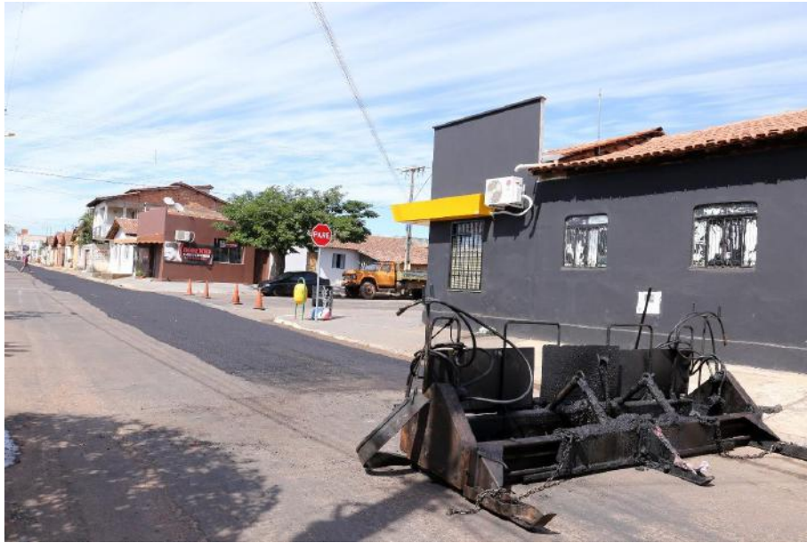
Figura 3. Processo de tamponamento com asfalto diluído de petróleo
