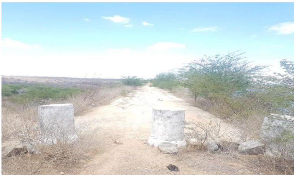
Figura 3: passarela de acesso ao Reservatório.
