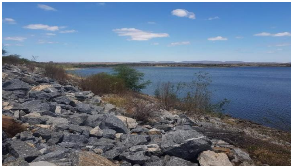
Figura 2: Barragem do Mucutu-Barreiras de contenção.
