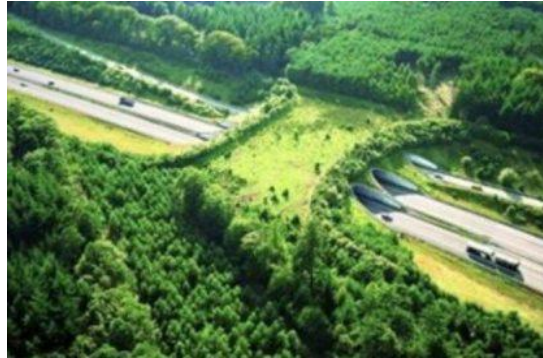
Figura 1 - Viaduto vegetado sobre a rodovia A-50, Holanda.
