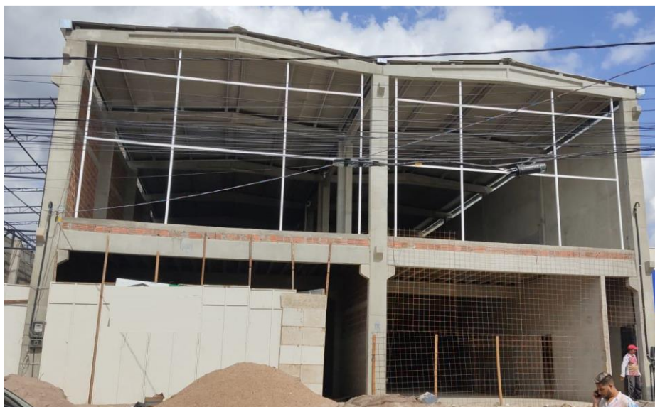
Figura 1 – Fachada da edificação estudada.
