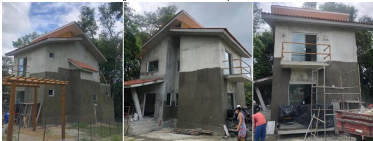
Figura 1 - Fachada do imóvel inspecionado.
