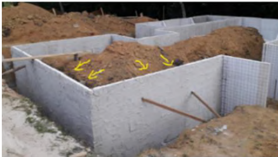
Figura 6 – A-Painel sendo usado como contenção.
