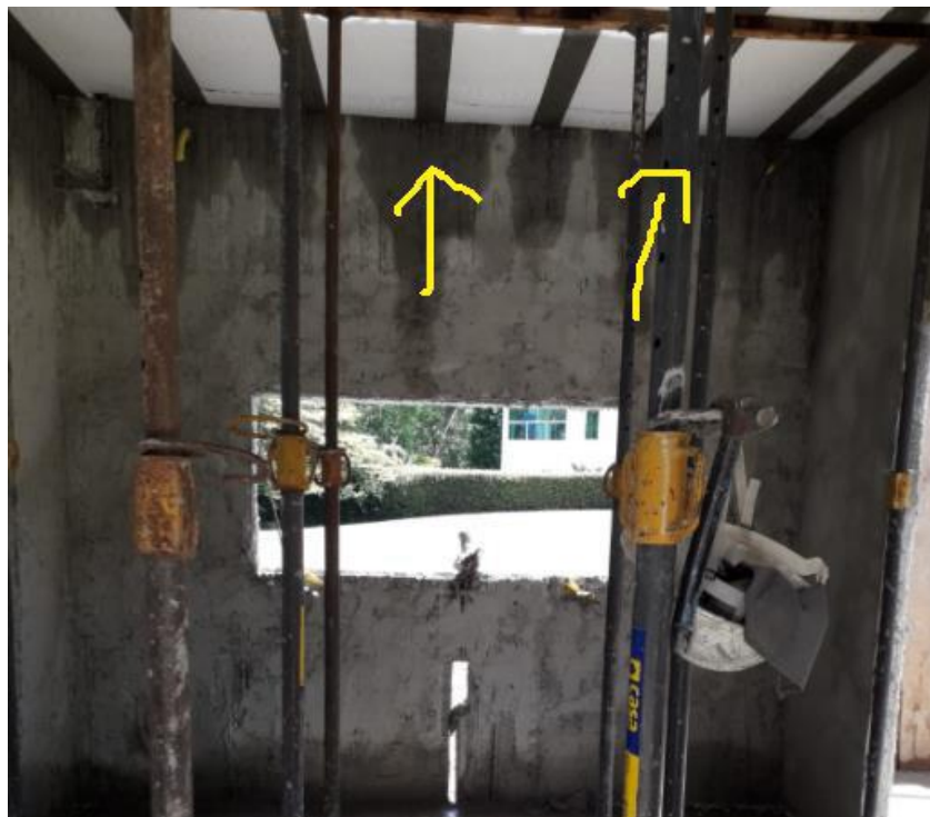
Figura 7 – Laje treliçada apoiada em painel EPS.
