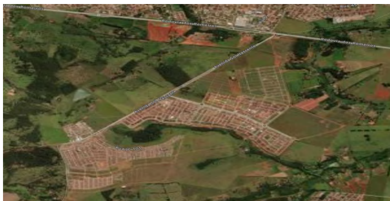
Figura 5: Conjunto Residencial Jardim do Cerrado. Goiânia.
