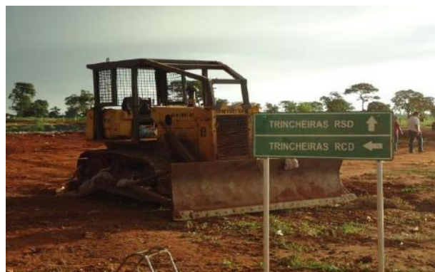
Figura 3 - Imagem do local de implantação do aterro de Santa Vitória-MG.
