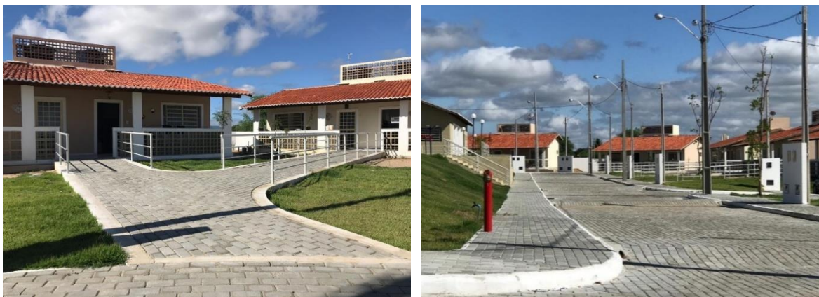
Figura 3 - Unidades habitacionais do Condomínio Cidade Madura em Patos-PB.
