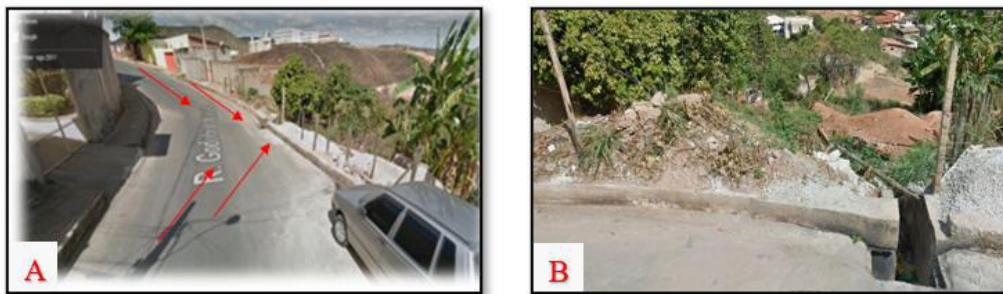
Figura 9. A) Direção do escoamento na rua Godofredo Mollendorff. B) Canal de drenagem.
