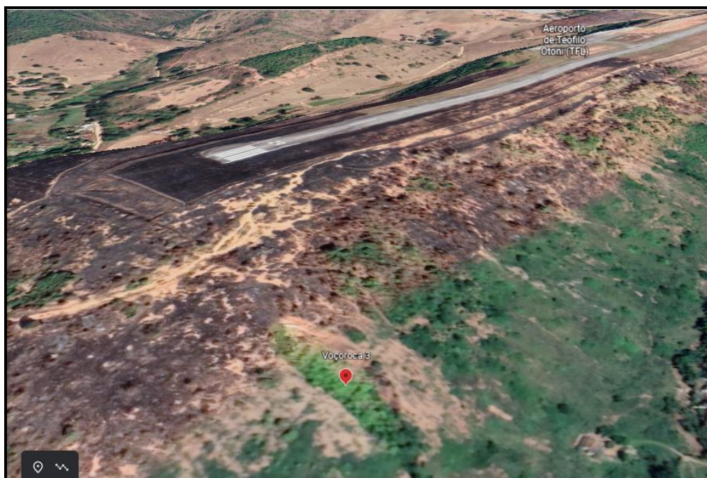
Figura 15. Imagem 3D de 2018 do talude onde está localizada a voçoroca 3.
