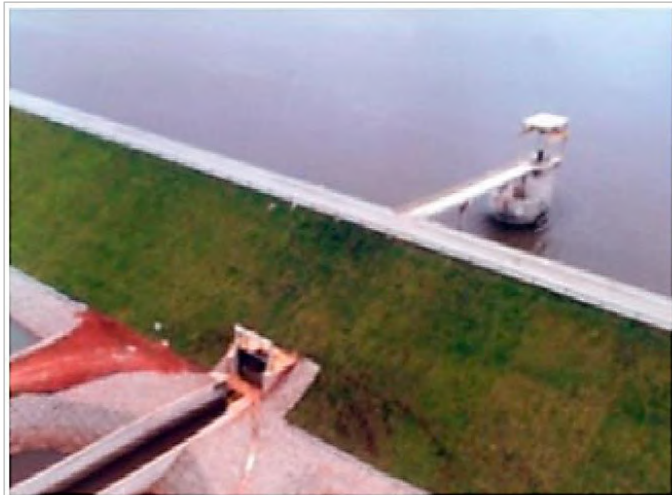
Figura 8 - Proteção do talude de jusante com cobertura vegetal.
