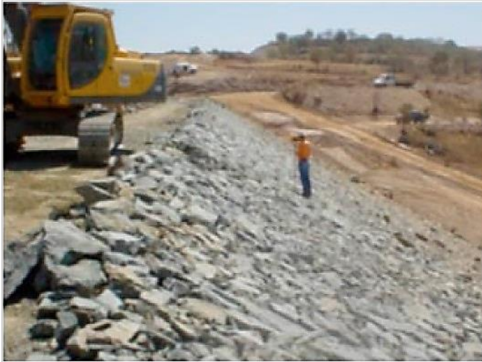
Figura 6 - Proteção do talude de montante em enrocamento.
