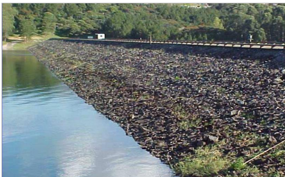
Figura 7 - Talude de montante de barragem com rip-rap.
