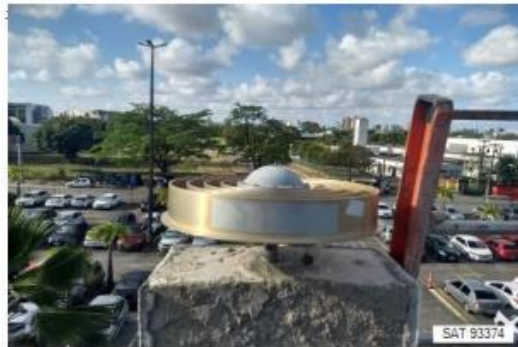
Figura 5a. Estação de referência PERC, instalada no prédio do IFPE.
