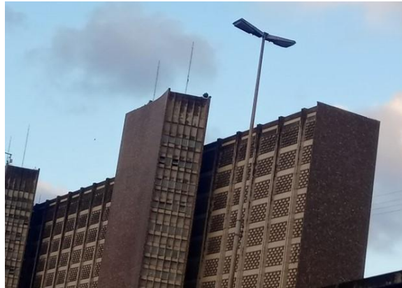
Figura 1. Edifício SUDENE. Recife (PE).
