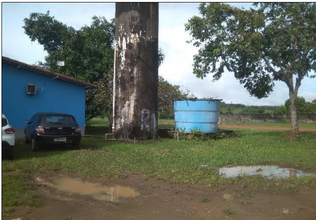
Figura 7: Poço de Captação de Água.
