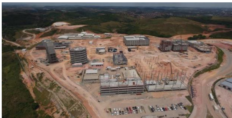
Figura 3. Desenvolvimento da obra em setembro de 2017.
