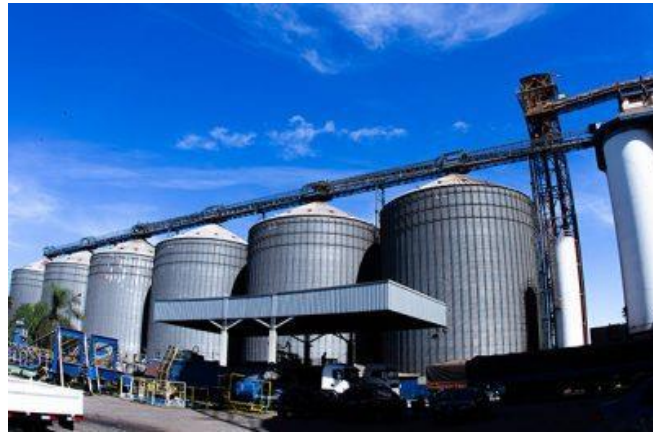
Figura 2: Silos presentes no Porto de Santos.
