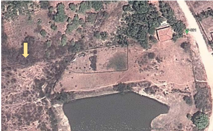
Figura 2 – Detalhes de Infraestrutura exibidas na Imagem Satélite.
