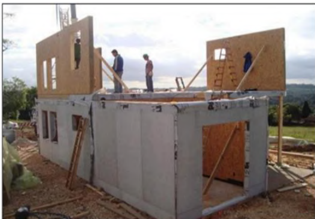
Figura 1 - Sistema industrial aberto em Wood Frame.
