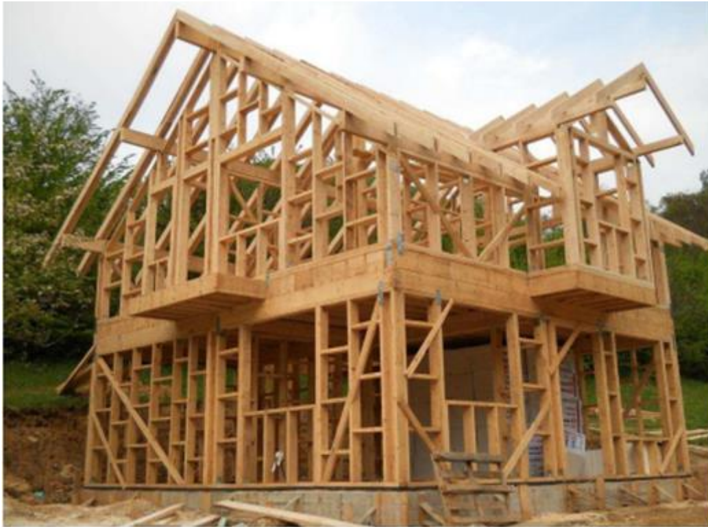
Figura 2 - Construção em Wood Frame.
