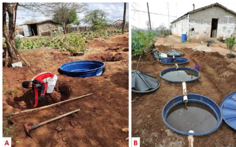
Figura 4 – Processo de construção da fossa biodigestora.
