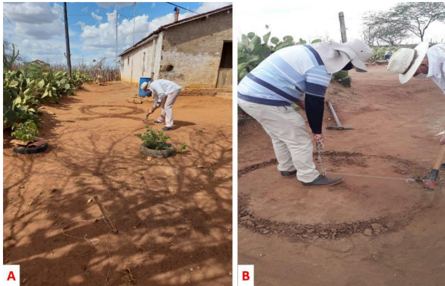
Figura 3 – Demarcação do local de instalação da fossa biodigestora.
