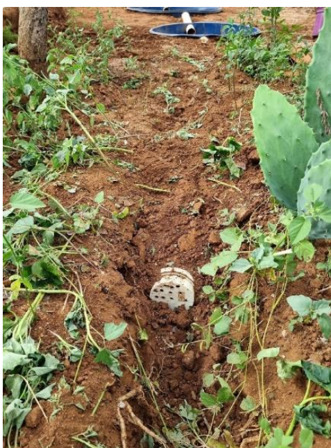
Figura 12 – Lançamento do efluente tratado na área contendo plantio de palma forrageira ( Opuntia ficus-indica (L.) Mill.).
