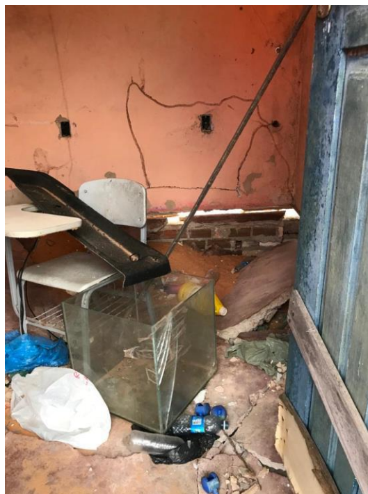
Figura 6 - Vista interna imóvel 5 da Área 1.
